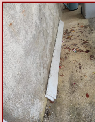
Dépôt de déchets au cimetière.
